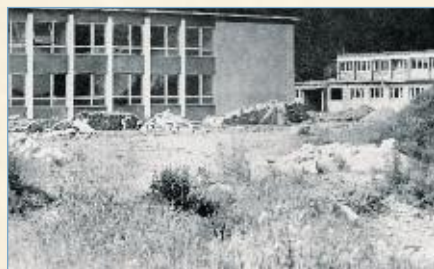
Z výstavby školy...
